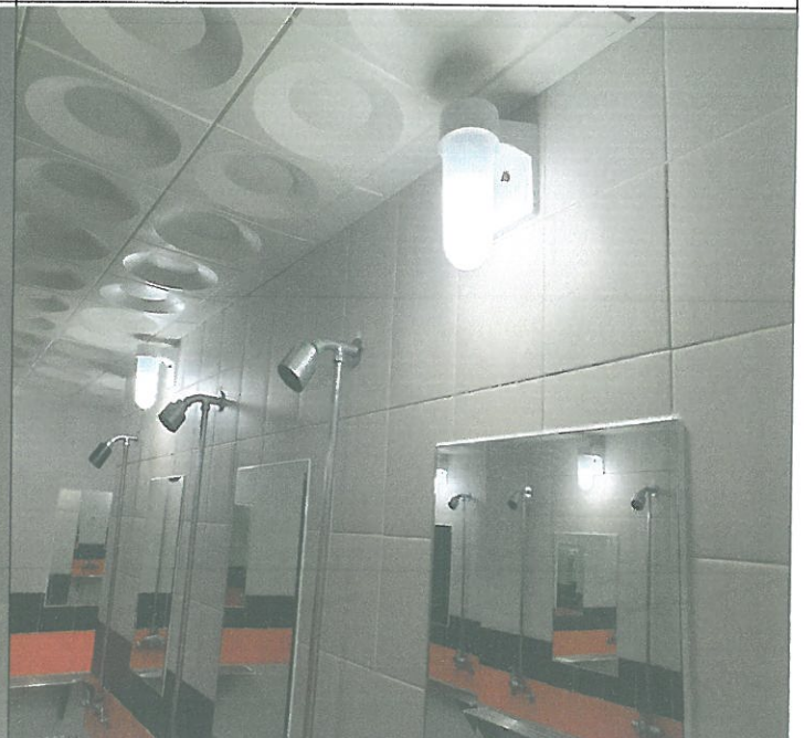
수영장 여자 샤워실 벽등 1개소 전구 교체
