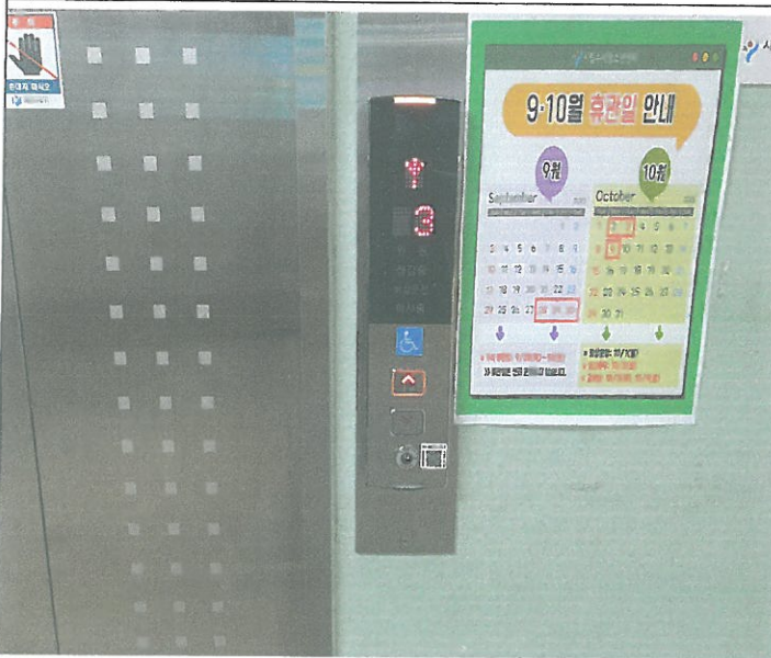
1층 승강기 탑승 층 올라감 버튼 교체
