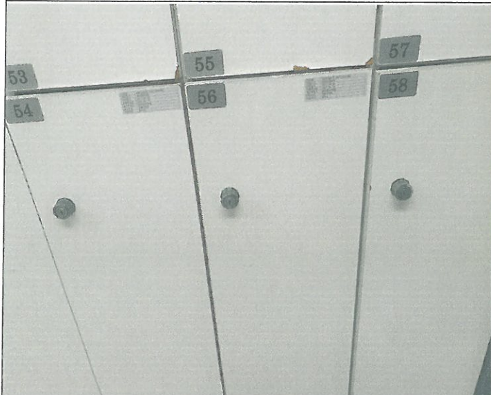
수영장 남자 탈의실 락카 문짝 1기 단락 보수
