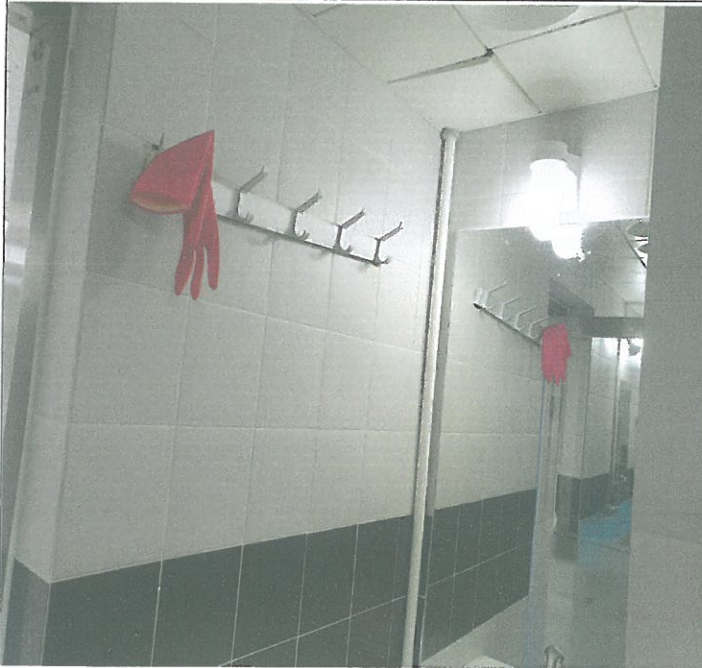
수영장 남자 샤워실 벽등 1개소 전구 교체
