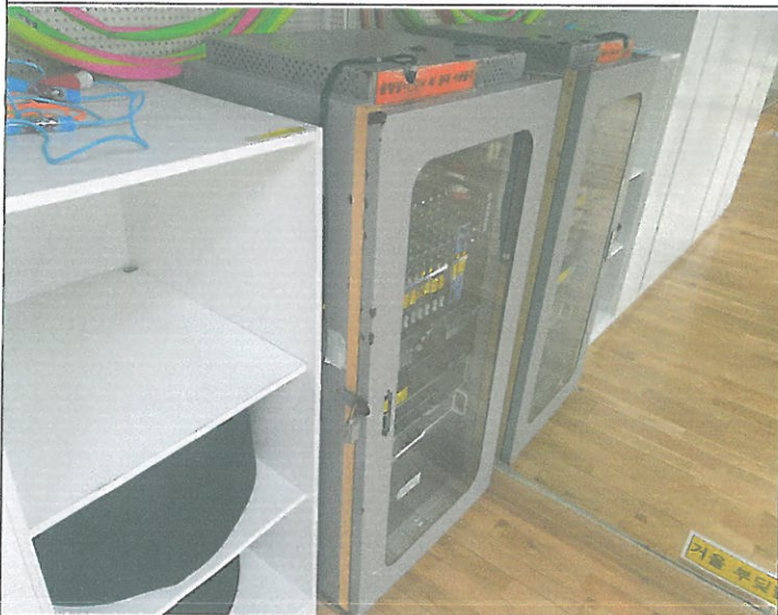
지하1층 소체육관 음향기기 문짝 교정 설치작업
