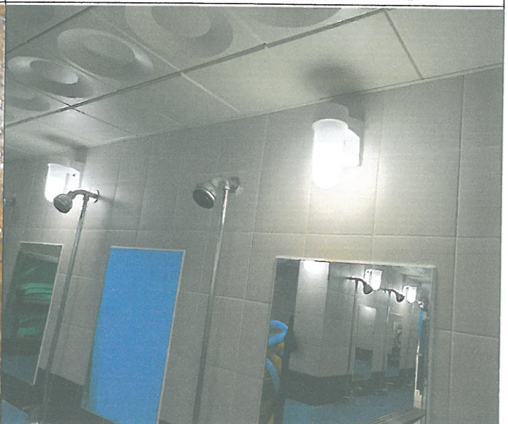
수영장 남자 샤워장 벽등 1개소 교체
