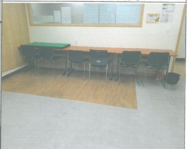
지하1층 아지트 바닥 단상마루 해체 작업
