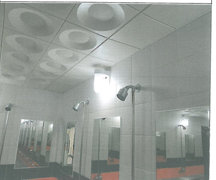
수영장 여자 샤워장 벽등 1개소 교체
