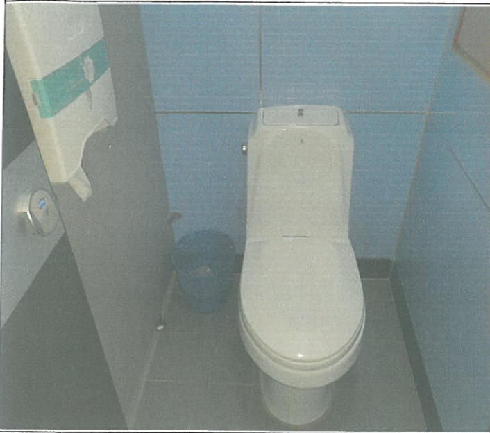
3층 남자 화장실 변기 커버 볼트 파손 교체
