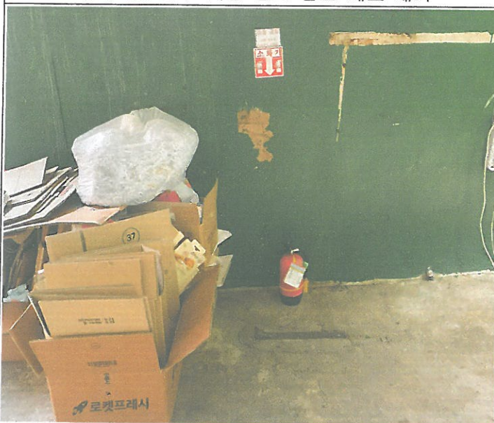
쓰레기장 소화기 파손 교체
