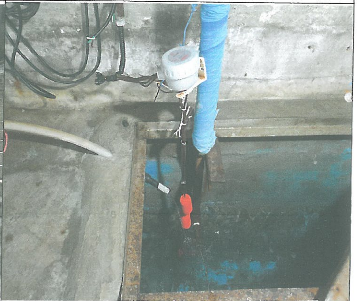
수영장 바란싱탱크 수의 조절 센서 교체
