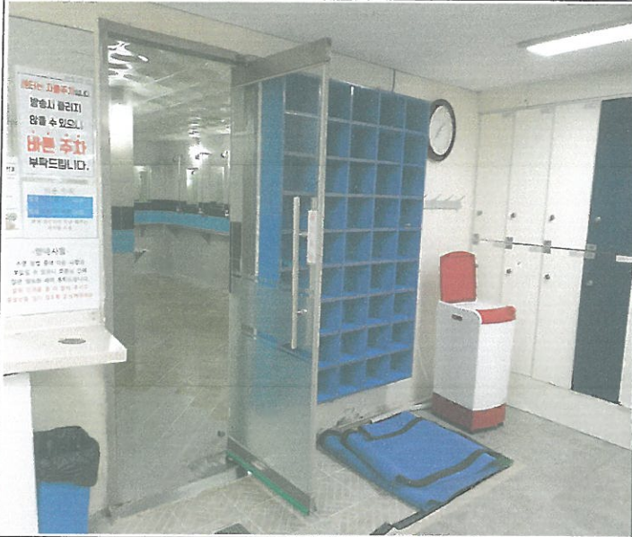
수영장 남자 탈의실 샤워실 출입 강화문 하부 힌지 교체
