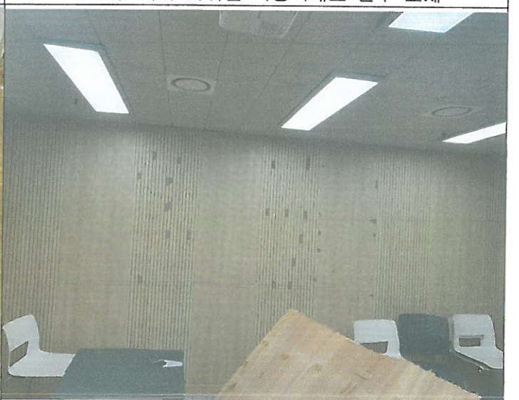
지하1층 아지트 1 철판 철거
