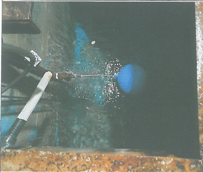
자하 바란싱 탱크 볼탑 파손 교체
