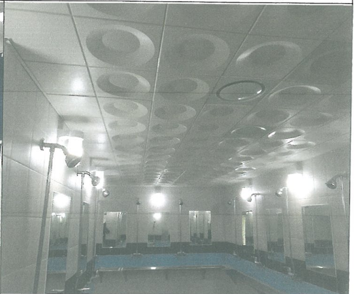
수영장 샤워실 남. 여 배기 그릴 교체
